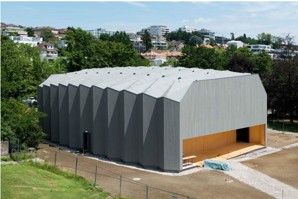
Figure 1 : Vue extérieure du nouveau pavillon bois du théâtre de Vidy-Lausanne
