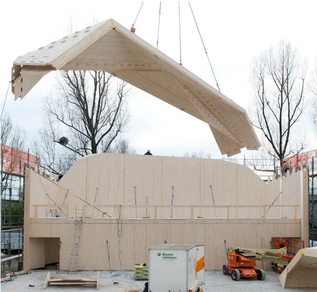
Figure 6 : Insertion d'un élément de toiture préfabriqué grâce aux connexions bois/bois
