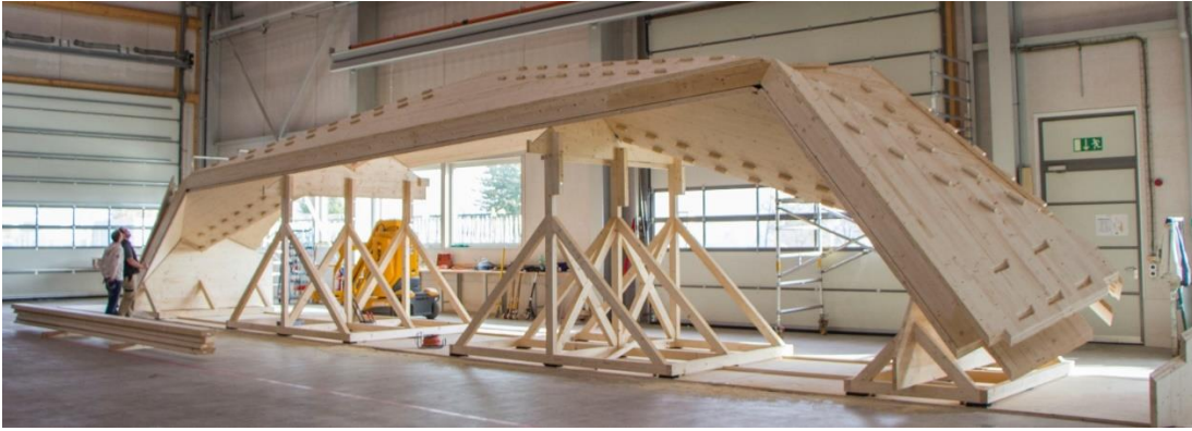
Figure 5 : Préfabrication de la toiture en atelier avant son acheminement sur chantier
