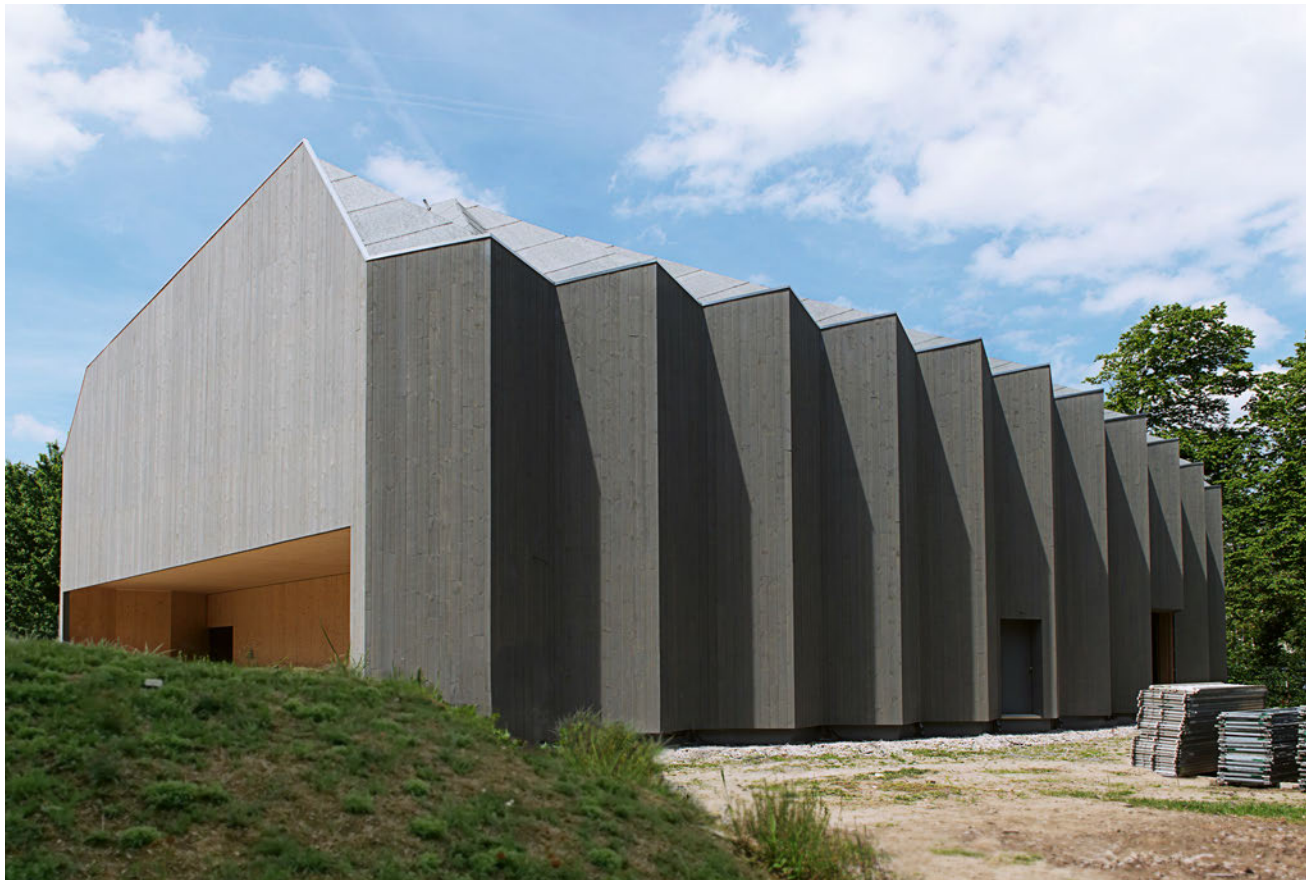
Als Faltwerk konstruierte Binder , zusammengesetzt aus Holzplatten, bilden den 9 m hohen, 28 m langen und 20 m stützenfrei überspannenden Raum des Théâtre de Vidy .
